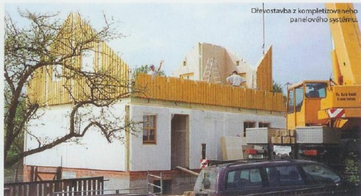
Dřevostavba z kompletizovaného panelového systému.
