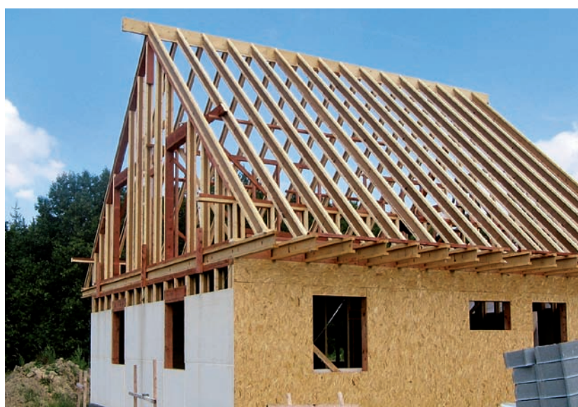
Obr. 3: Dřevoláknitá tepelná izolace, I-nosníky a stavební desky – vše z konstrukčního a izolačního systému STEICO – používá pro své stavby firma Akastav.
